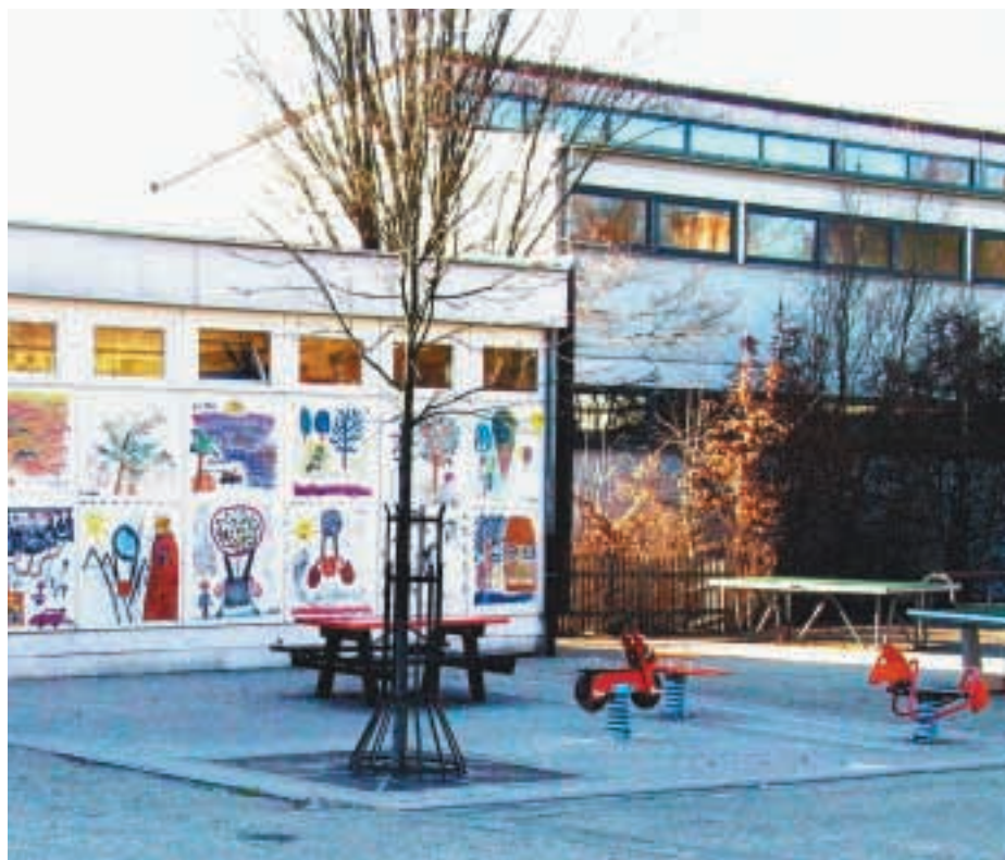
Der Brandschutz in der Heumaden-Schule muss auf den neuesten Stand gebracht werden
