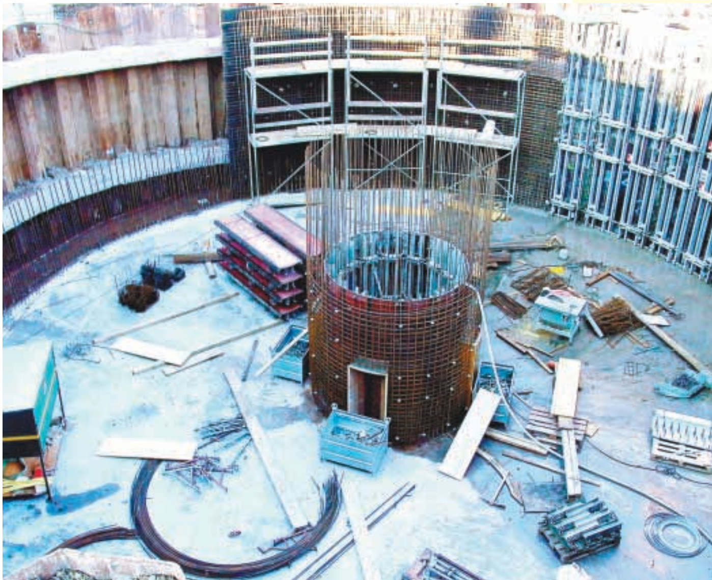
Der nächste Bauabschnitt am Regenüberlauf Freibad in Stammheim wurde jetzt vergeben: es geht um Mess-, Steuer- und Regeltechniken
