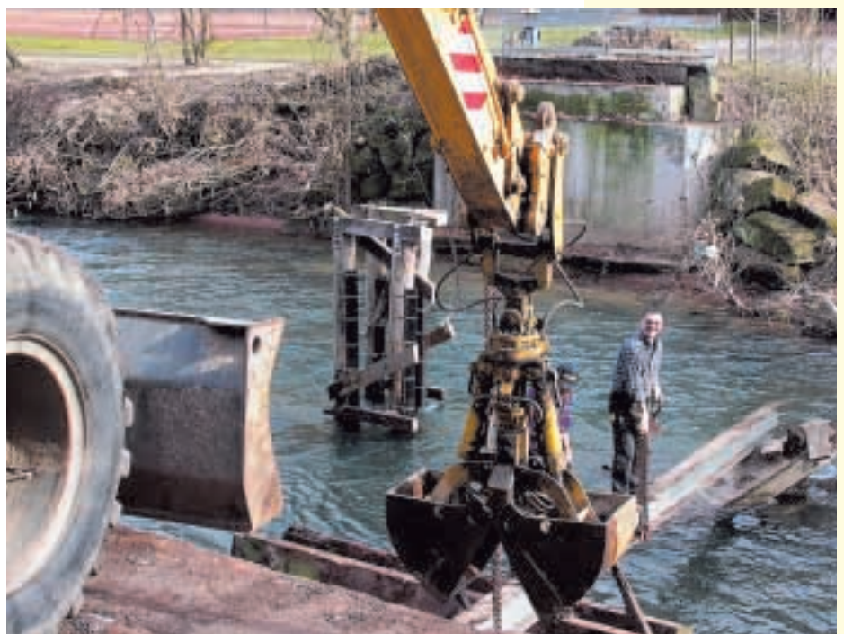
Der Abriss der alten Nagoldbrücke war aus Sicherheitsgründen nicht mehr zu umgehen
