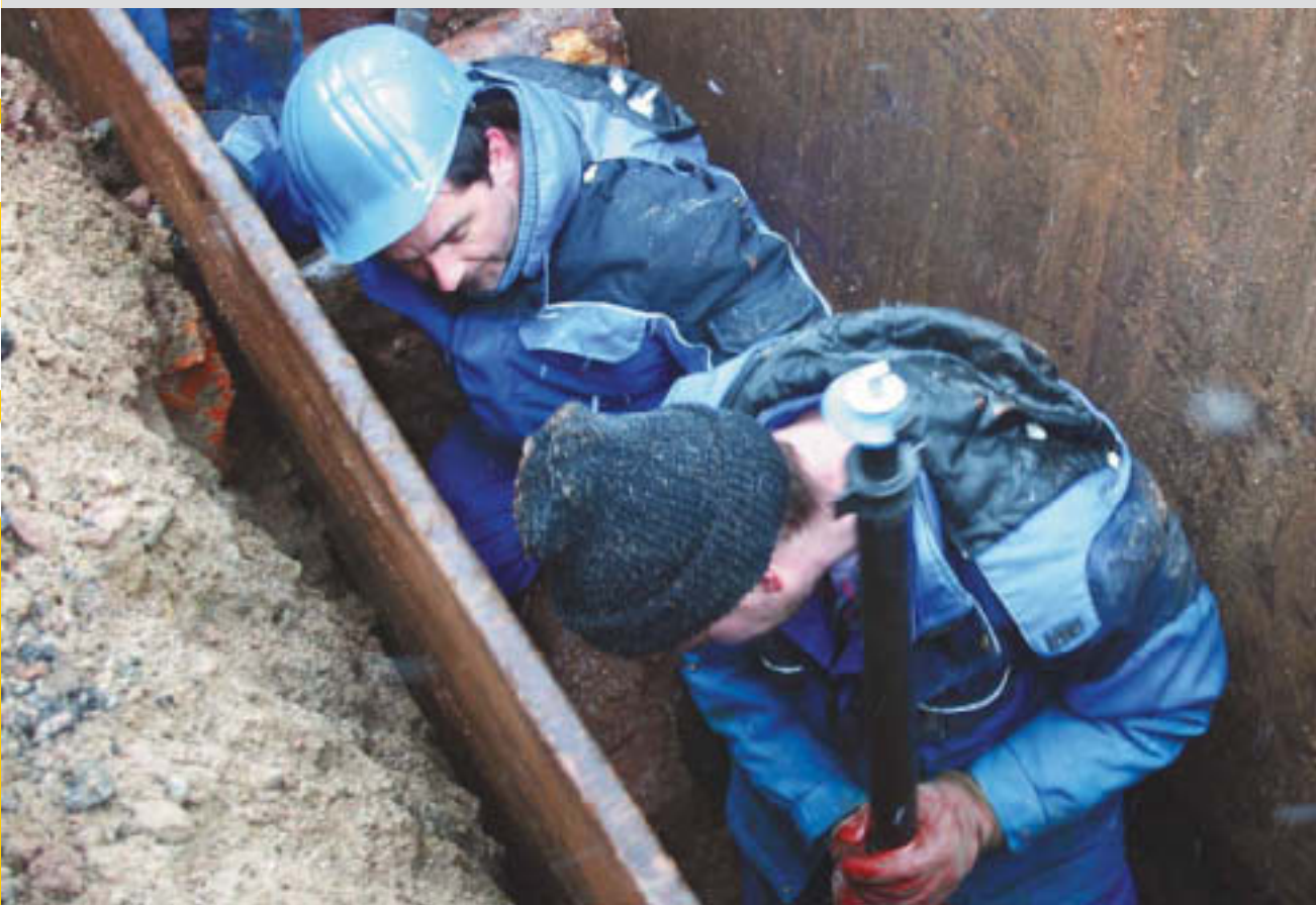
Die Mitarbeiter der Stadtwerke sind unermüdlich im Einsatz, Schäden zu orten und zu beheben
