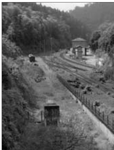
In Calw Süd wird weiter gearbeitet
