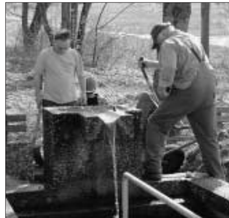
Inbetriebnahme der neuen Wasserleitung
