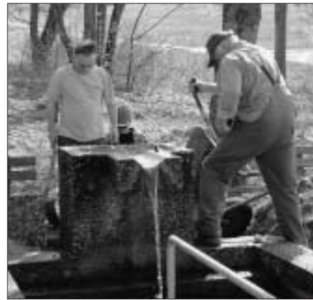
Inbetriebnahme der neuen Wasserleitung
