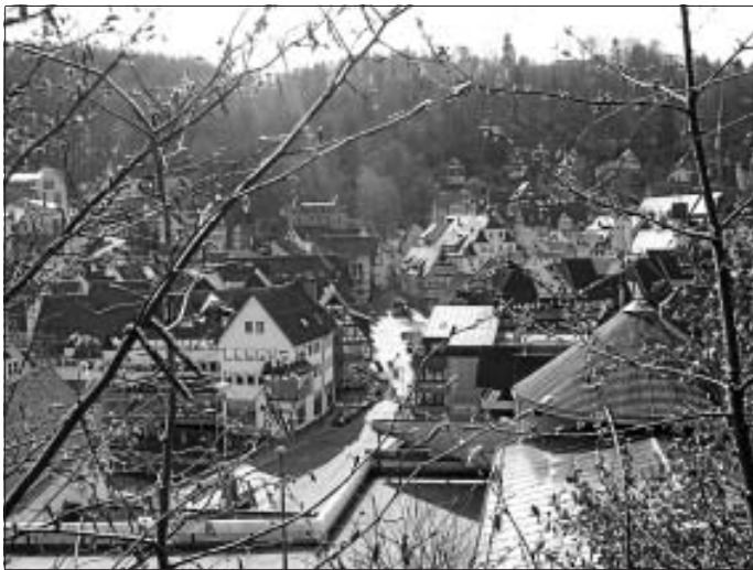
Blick vom künftigen Haltepunkt der Schwarzwaldbahn direkt auf die Calwer Innenstadt.
