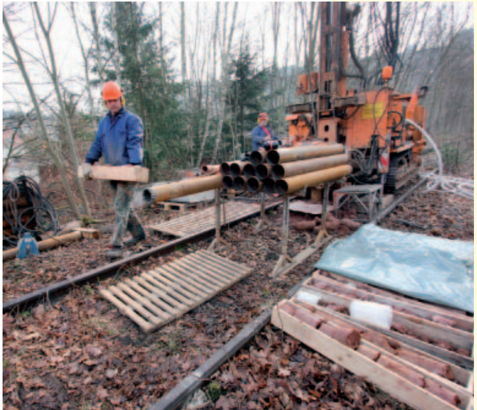
Zwei Bohrtrupps sind derzeit entlang der Trasse des geplanten Calwer Tunnels im Einsatz
