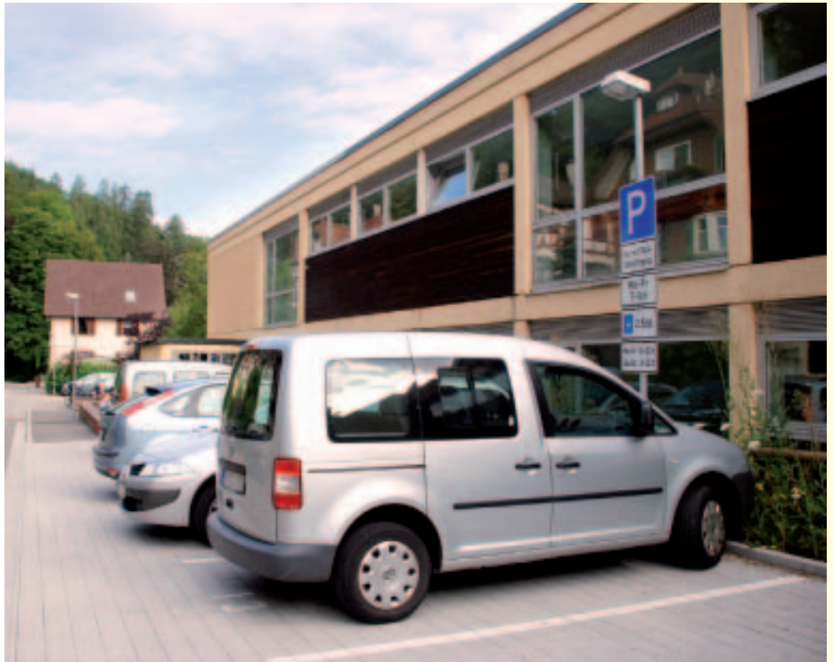
In der Hermann-Haffner-Straße stehen nun werktäglich ab 16 Uhr und an den Wochenenden Kurzzeit-Parkplätze kostenlos und für die Dauer von zwei Stunden zur Verfügung
