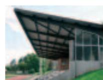
roden Fußpunkten der Kragkonstruktion hauptsächlich aufklaffende Leimfugen. Diese Klebverbindungen konnten den äußeren Einflüssen aus Witterung, Feuchte, Wärme und Belastung wohl nach ersten Einschätzungen nicht mehr standhalten. Der schleichende Prozess ist soweit fortgeschritten, dass eine Sperrung unumgänglich wurde. Inwieweit eine Sanierung möglich ist, wird derzeit überprüft.
