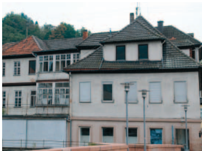
Derzeit werden für das altherwürdige Haus Reichert Sanierungspläne geschmiedet
