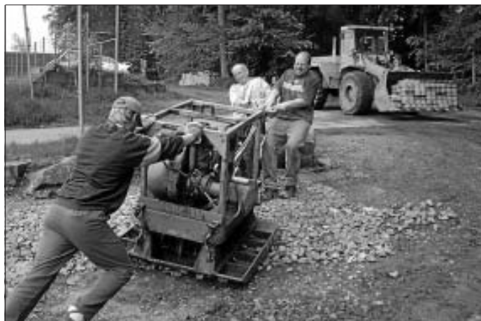
Mit Muskelkraft und Maschinen werden hier gerade Parkplätze angelegt.
