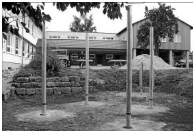
Grundschule bekommt neues Klettergerüst
