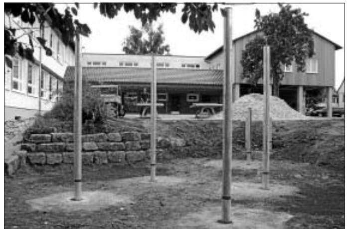
Grundschule bekommt neues Klettergerüst
