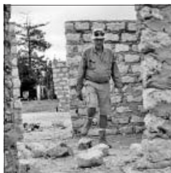
Ralph Stephan im Rohbau des Waisenhauses
