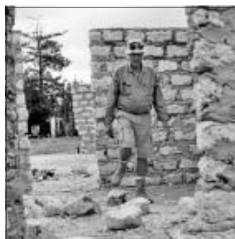
Ralph Stephan im Rohbau des Waisenhauses
