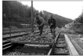
Arbeitseinsatz am Stellwerk
