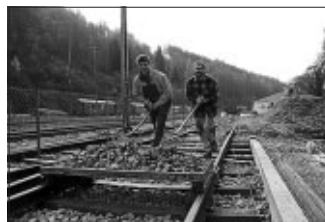
Arbeitseinsatz am Stellwerk
