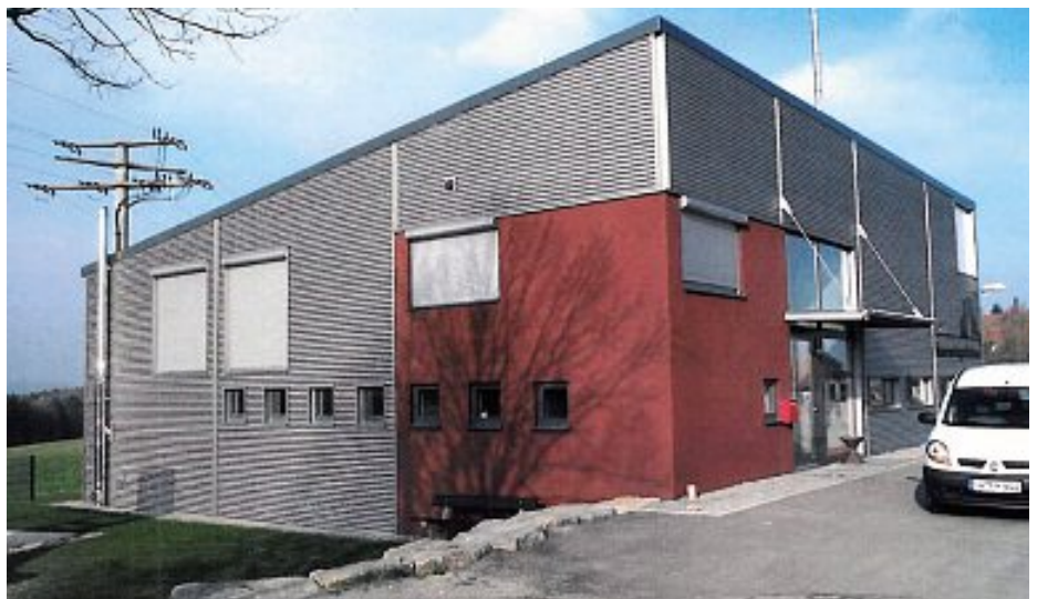
Das Feuerwehrhaus in Bad Herrenalb-Rotensol – die Bauweise wird auch in Altburg angewandt
