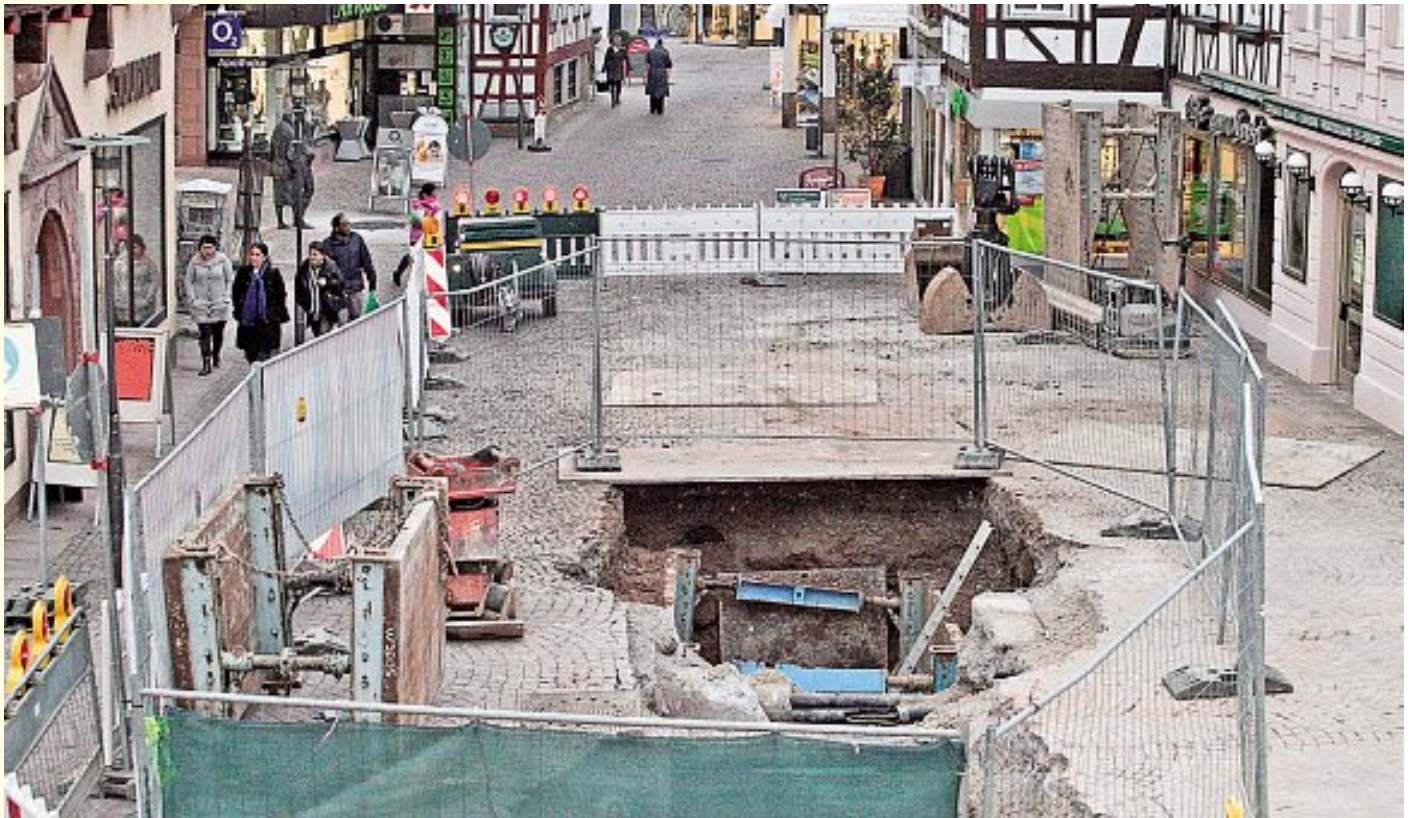
Die Baustelle für die neue Abwasserleitung ist in der Marktstraße angekommen
