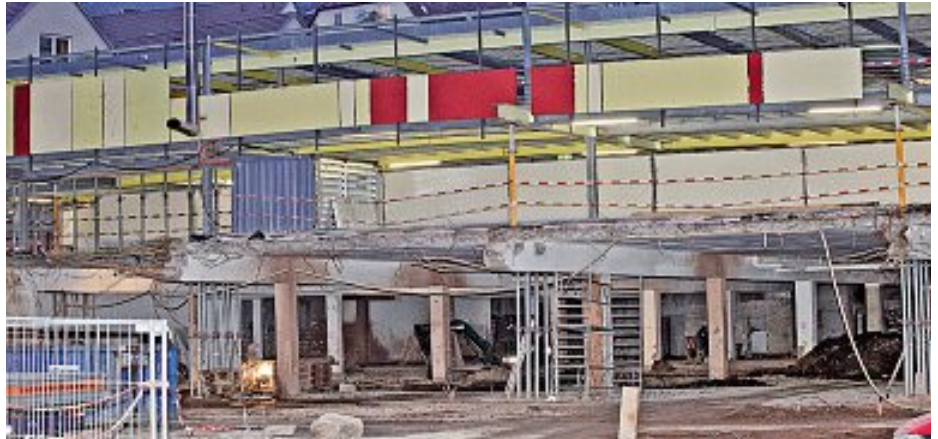
Bauarbeiten am unteren Ledereck, nachdem das alte AWG-Gebäude abgerissen wurde
