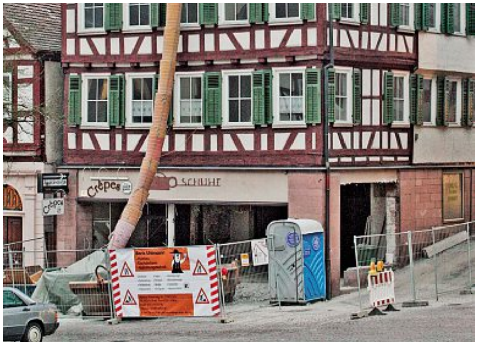
Die alte Kaufstätte am Marktplatz 1 wird für rund 2,3 Millionen Euro vollständig saniert
