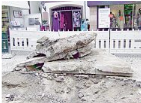
Die Betonplatten erschweren die Arbeiten
