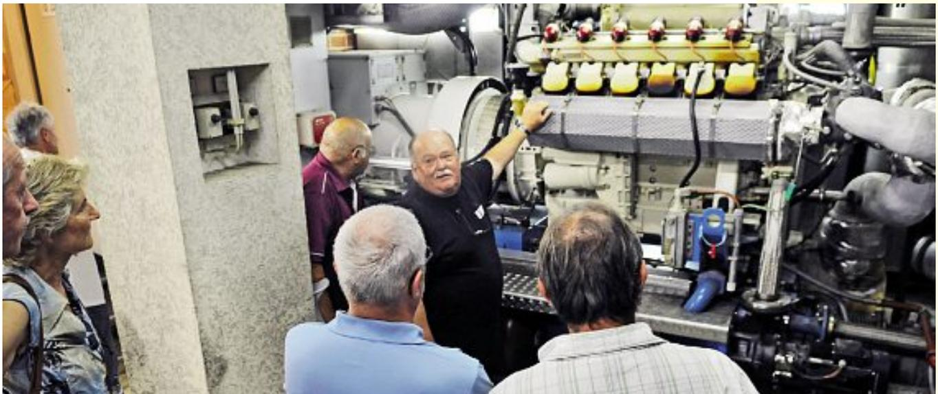
Emissionsarm und extrem effizient: Seit 1988 verrichtet das Blockheizkraftwerk am Calwer Hallenbad seinen umweltfreundlichen Dienst. Mit einer elektrischen Leistung von 360 KW und einer thermischen Leistung von 469 KW machen die 530 PS
