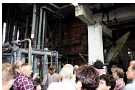
Einblicke in das Kesselhaus
