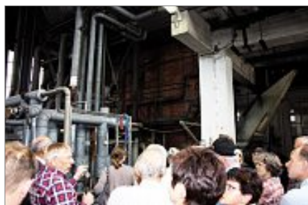
Einblicke in das Kesselhaus
