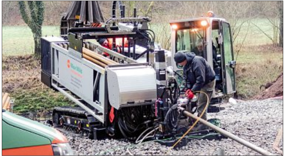
Die Pilotbohrung ist in vollem Gange
