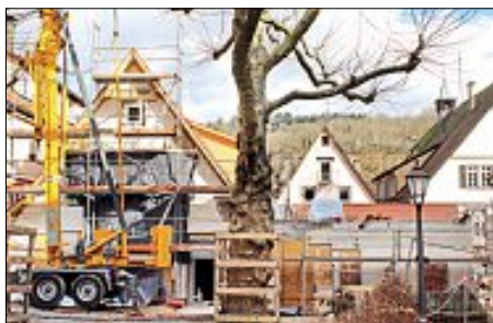
.....hier wird auf Hochtouren gearbeitet....
