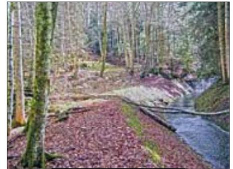
und am Ende über Absturzkaskaden wieder in die Talsohle geführt. „Nach Rückverlegung des Tälesbachs in die Mitte der Auffüllung dient der Umfluter als Hochwasserentlastung.“
